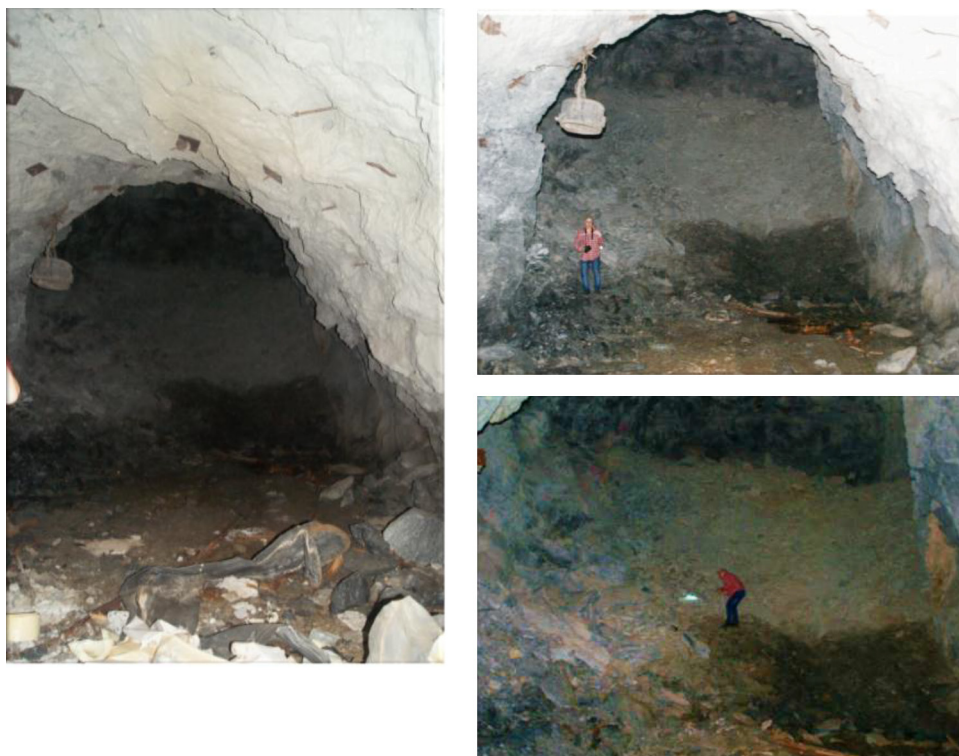
Рис. 2. Фотография полости в тоннеле на расстоянии 2620 м от входа
