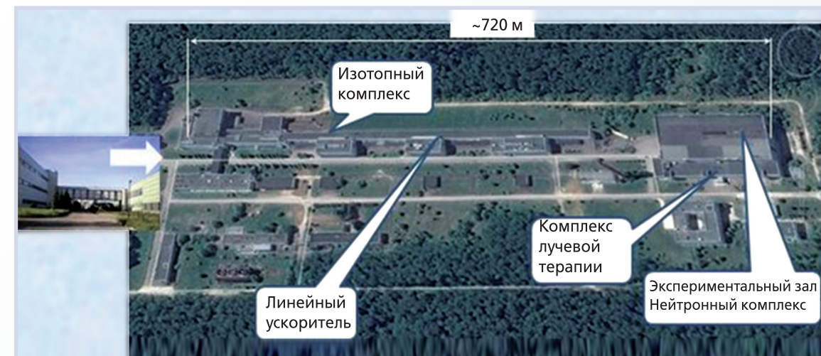
Комплекс сверхточного линейного ускорителя
